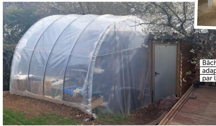
Bâche polyéthylène sur mesure adaptée à une armature réalisée par l'un de nos clients.
