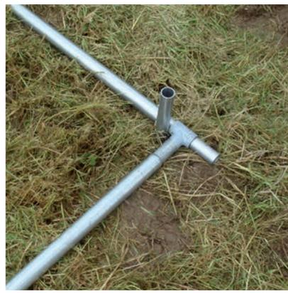
Assemblage du tube de façade
